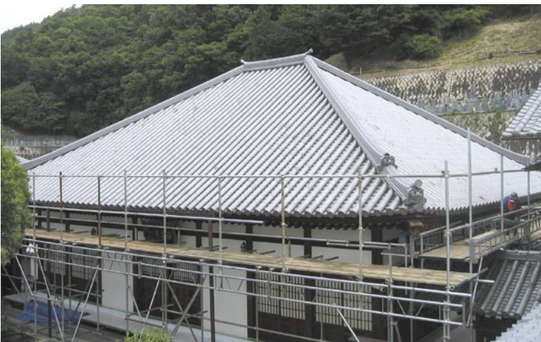
完了した本堂の屋根修理
