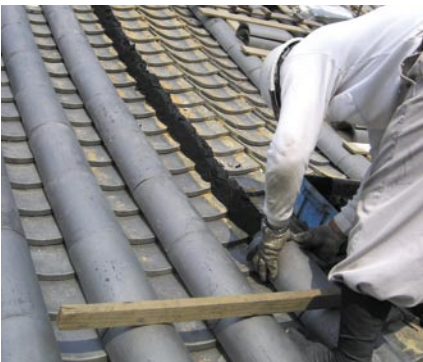
新建材の「なんぼん」で瓦を接着する
