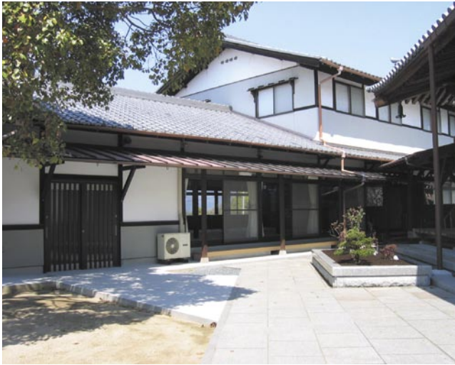
改修工事の終わった檀信徒会館
