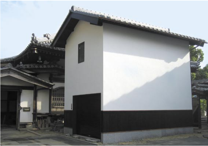
本堂の隣に完成した倉庫外観
