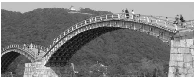
架け替え工事が完了した錦帯橋を渡橋
