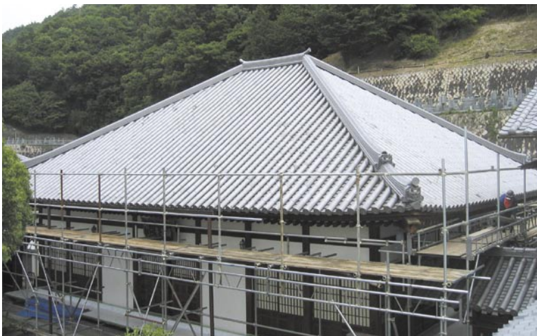
完了した本堂の屋根修理
