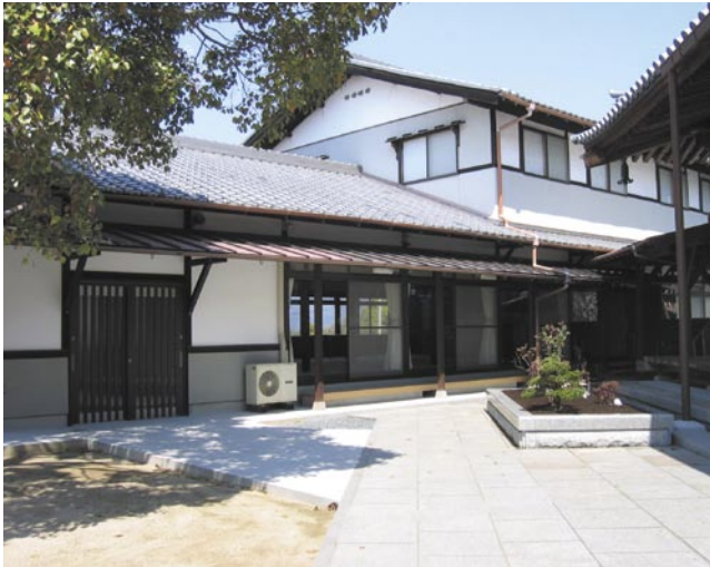
改修工事の終わった壇信徒会館
