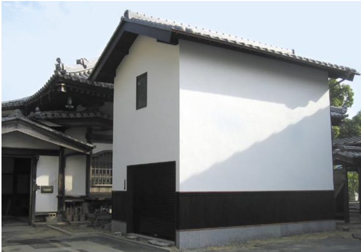
本堂の隣に完成した倉庫外観
