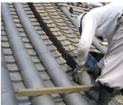
新建材の「なんばん」で瓦を接着する
